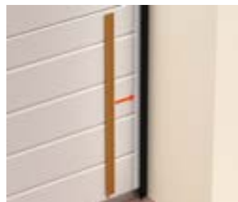
Устанавливаем боковой профиль под правую боковую крышку нижней сэндвич-панели.
