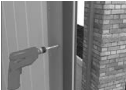
Просверлите 2 отверстия \varnothing 12 в створке.
