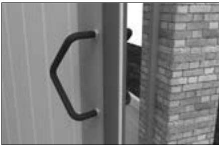
Разметьте отверстия для установки ручки.
