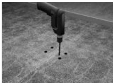
Просверлите 4 отверстия \varnothing 13 в дорожном покрытии.
